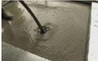
Mortero autonivelante espumado
